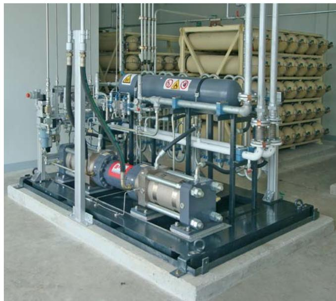
Compressore idraulico BOOSTER
